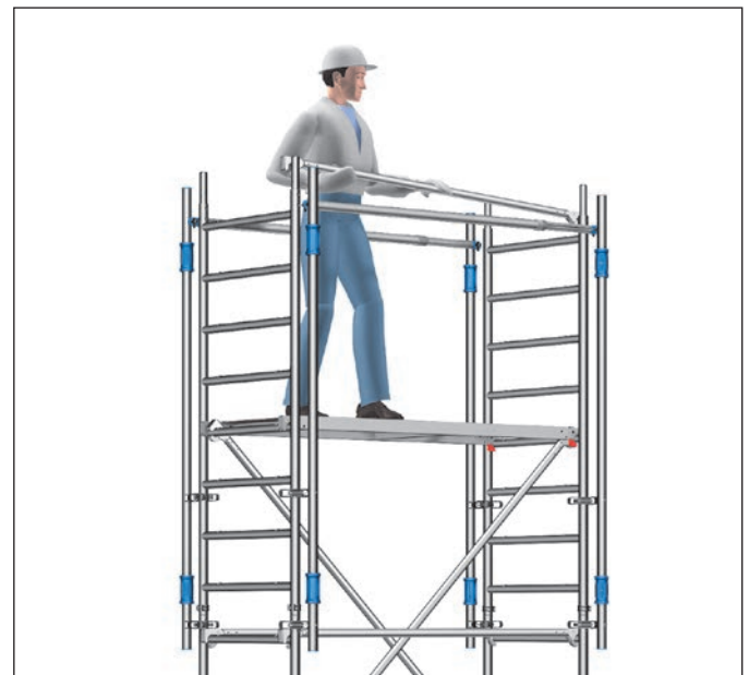
Bild 6: Sichere Montage der Rückenlehnen mit MSG
